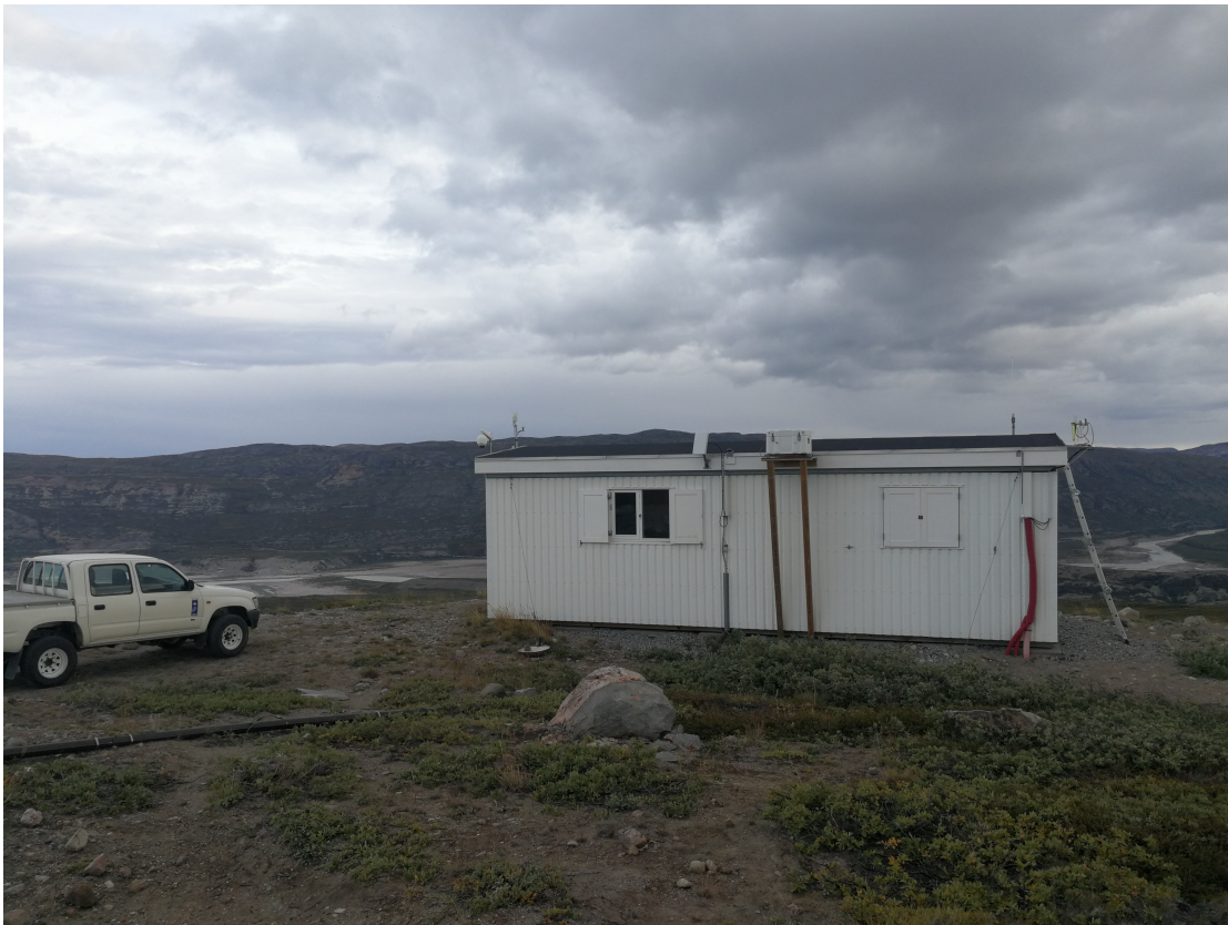
Fig. 1.1: Observationshytten i Kangerlussuaq. SAOZ-spektrometeret ses monteret midt på hytten. I bygningens højre ende ses Aeronet-solfotometeret. Brewer-spektrometre står bag ved fotografen.
