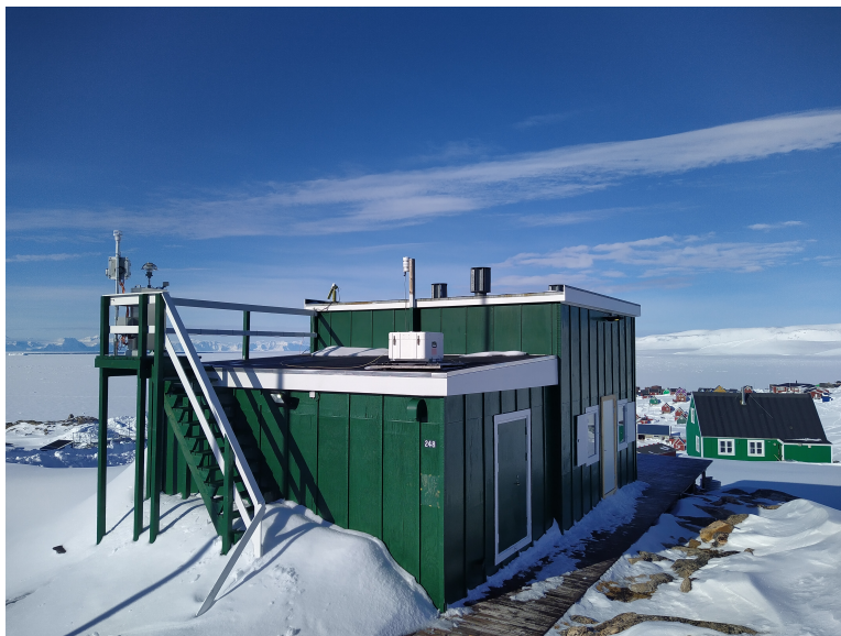
Fig. 1.1: Radiosondestation i Ittoqqortoormiit, hvorfra ozonsonder opsendes. Saoz og GUV2511 ses på taget, forår2023.
