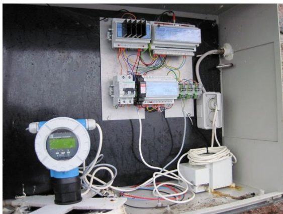
Elektronikskab – ultralyd, Nordre Røse Fyr (DMI)
